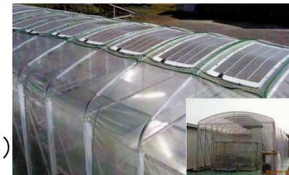
ビニールハウスへの設置
