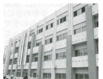
耐震補強された教室棟
