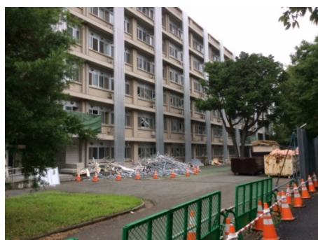
解体工事中の工学部1号館
