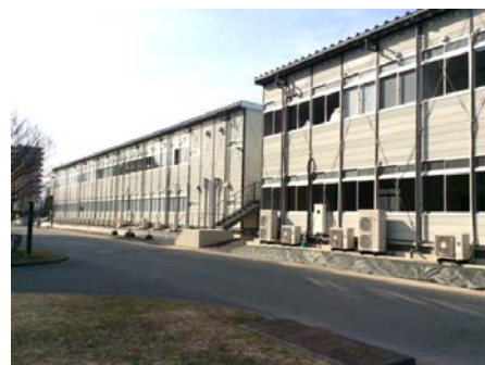
工学部仮設校舎B棟外観
