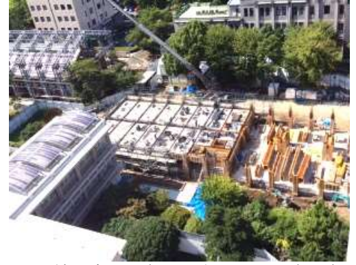
1 号館工事現場(2018 年 8 月 2 日撮影)
