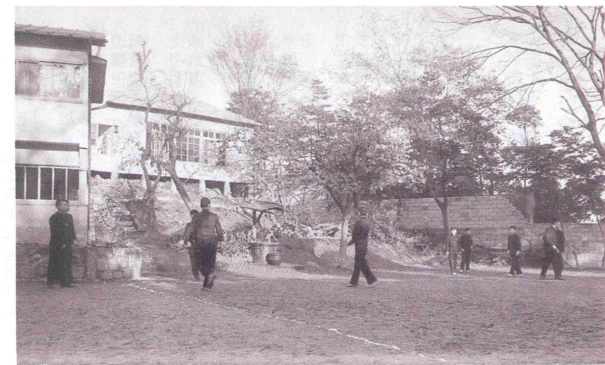
1960年、仮設校舎・グラウンド
